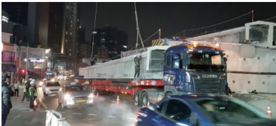
(6) 철거교량 거더 적재
