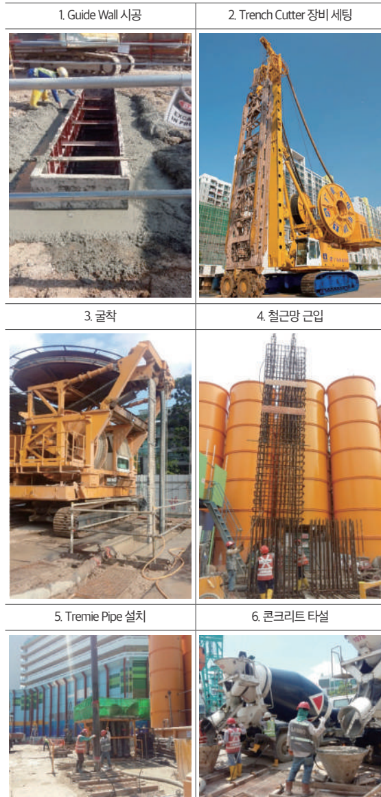
[그림 6] Dwall 시공순서
