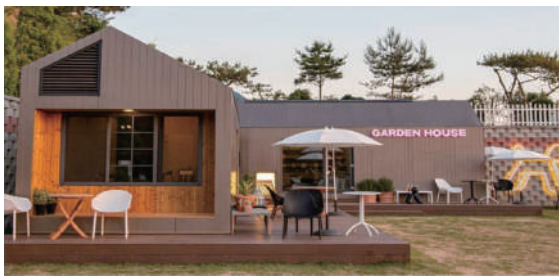
[그림 5] 간삼 ODM 주택 시공사례·남양주
