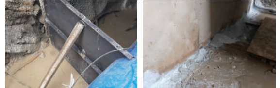
[그림 10] 버팀목 설치 및 누수 방지용 실링 작업 장면
