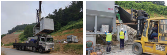
[그림 13] 장비 철수 등 현장 마무리 작업
