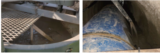
[그림 12] CLSM의 제조 및 충전 작업
