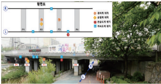
[그림 6] IoT 센서의 현장 구축 및 모니터링
