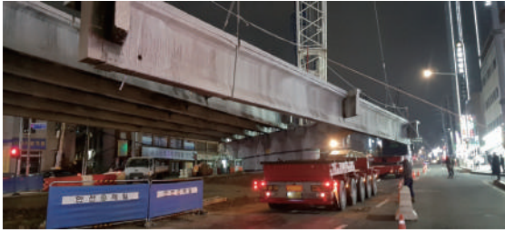
(5) 철거교량 거더 해체
