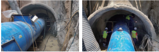
[그림 6] 충전관 및 Over Flow관 설치 장면
