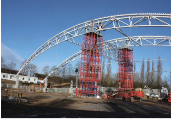
[그림 12] Temporary Supporting Tower(예)
