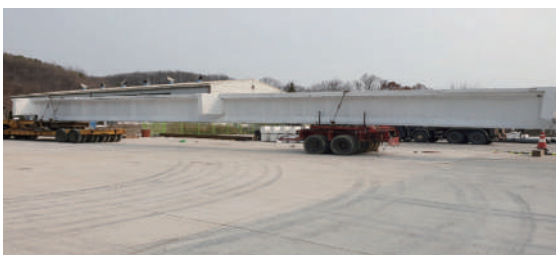
(7) 철거교량 거더 운송
