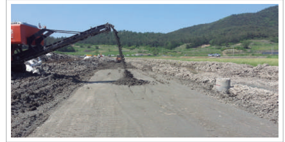
[그림 28] 연약지반 고화작업 중 전경
