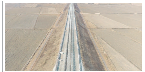
[그림 42] 연약지반 시공완료, 궤도부설
