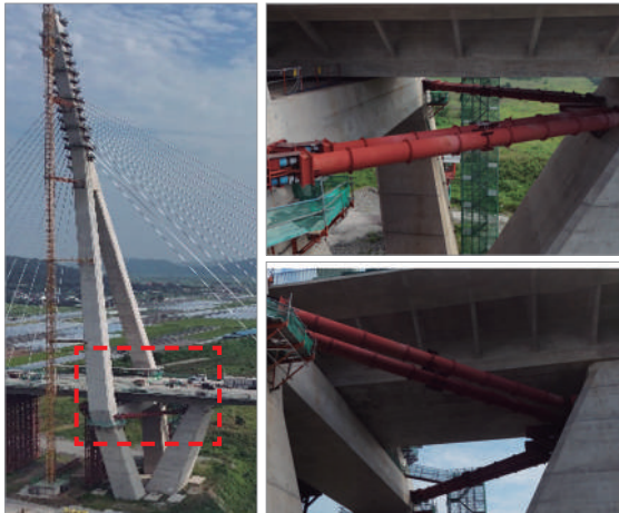
[그림 14] 임시 강재 가로보 설치 전경
