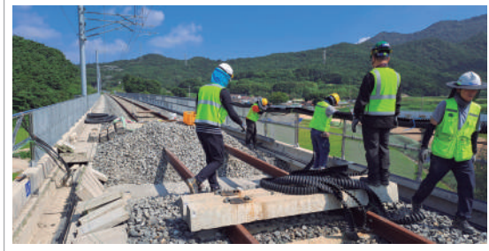
[그림 38] 영구앵커, 콘크리트 블럭 설치
