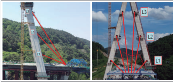
(c) 임시 타이 케이블 설치 전경
