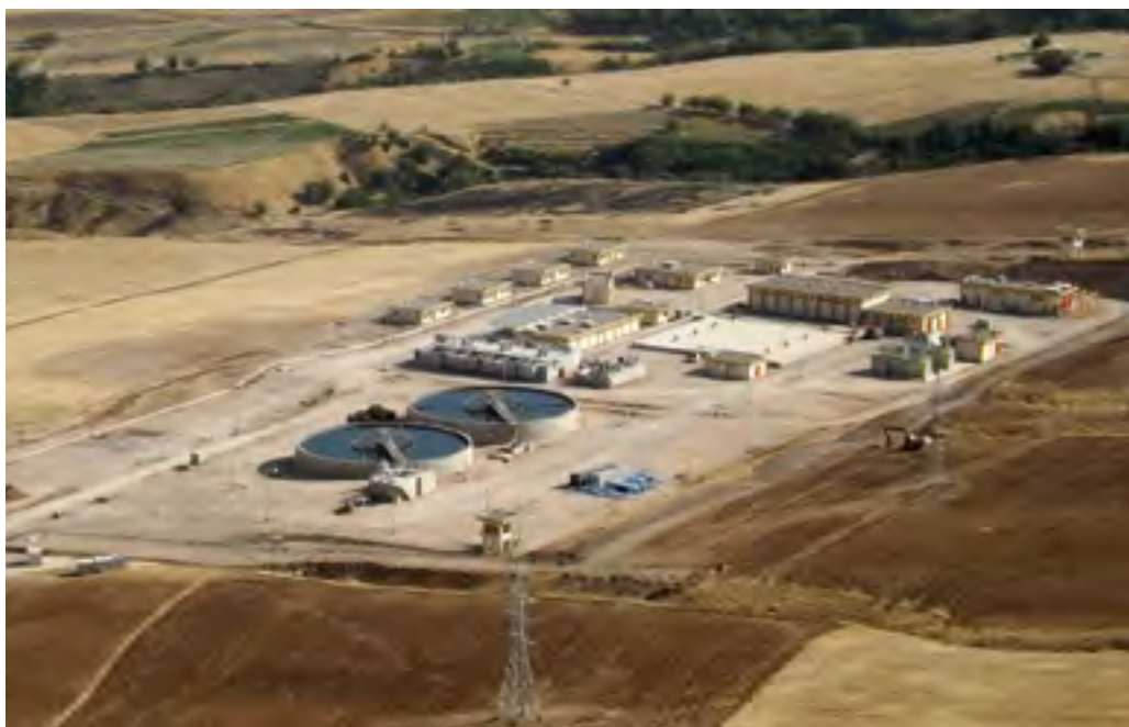
쿠르드 정수장 및 상수도 공사 (이라크 하랍자) 완공일 : 2016.05 발주처 : Ministry of Municipality and Tourism *술라이마니아 (Sulaymaniyah) 및 하랍자 (Halabja) 지역 15만명 분의 식수 공급 시설 (100,000m 3 /day) *원수 취수시설, 수직구, 정수처리 시설, 송수관로, 배수시설, 정수처리시설 확장 *배수관망 (하랍자 327km, 술레마니아 305km), 송수관로 (43Km)
