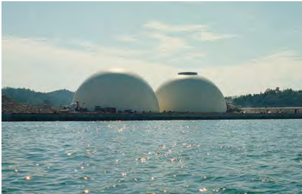
쌍용양회 대불 출하기지시설 (전남 목포) 완공일 : 1995.09
