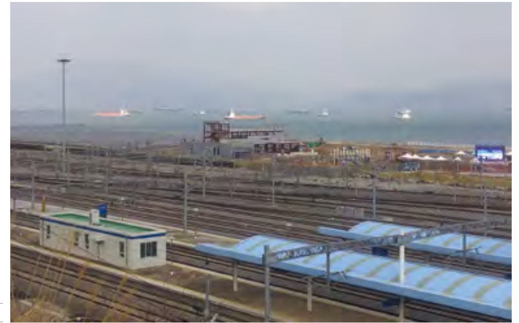
전라선 순천 - 여수간 철도전력 설비 (전남 순천, 여수) 완공일 : 2012.05
