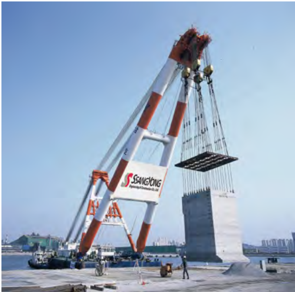
인천북항 일반부두 3선석 (인천 서구) 완공일 : 2009.05 *2만 톤급 선박 3척이 동시에 접안할 수 있는 시설 (케이슨식 안벽 700m)
