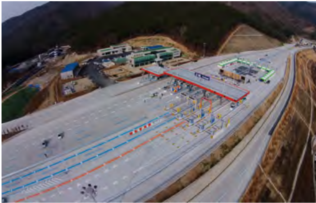
부산신항 제2배후도로 민간제안사업 1공구 (부산) 완공일 : 2017.01 L=5.7km
