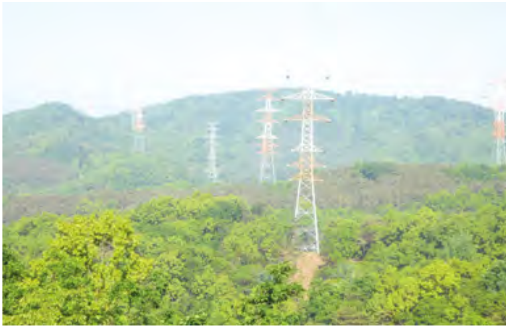
345kV 신의정부 송전선로 (경기 의정부) 완공일 : 2016.03
