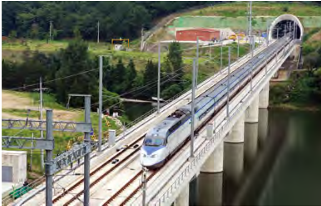
경부고속철도 대구 - 울산간 신호설비 (대구, 울산) 완공일 : 2010.12
