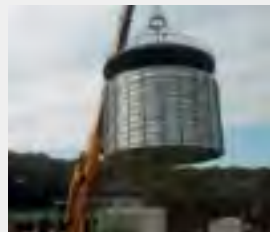
지하 74m까지 750톤 크레인으로 파형강관 시공
