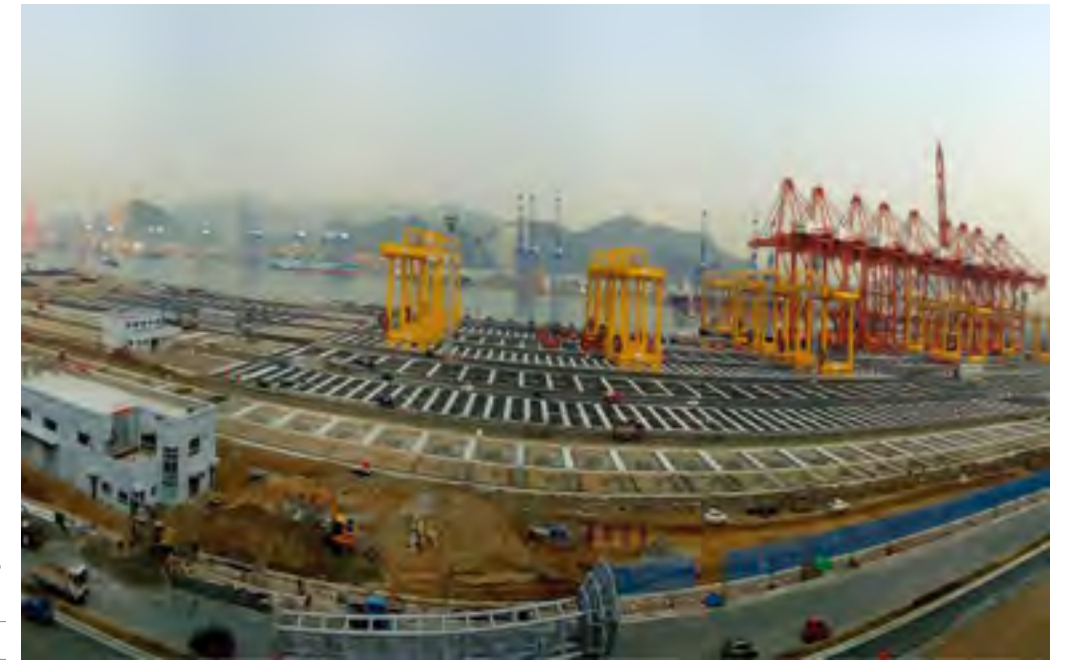
부산신항 남컨테이너 터미널 (202) 전기공사 (부산) 완공일 : 2010.12
