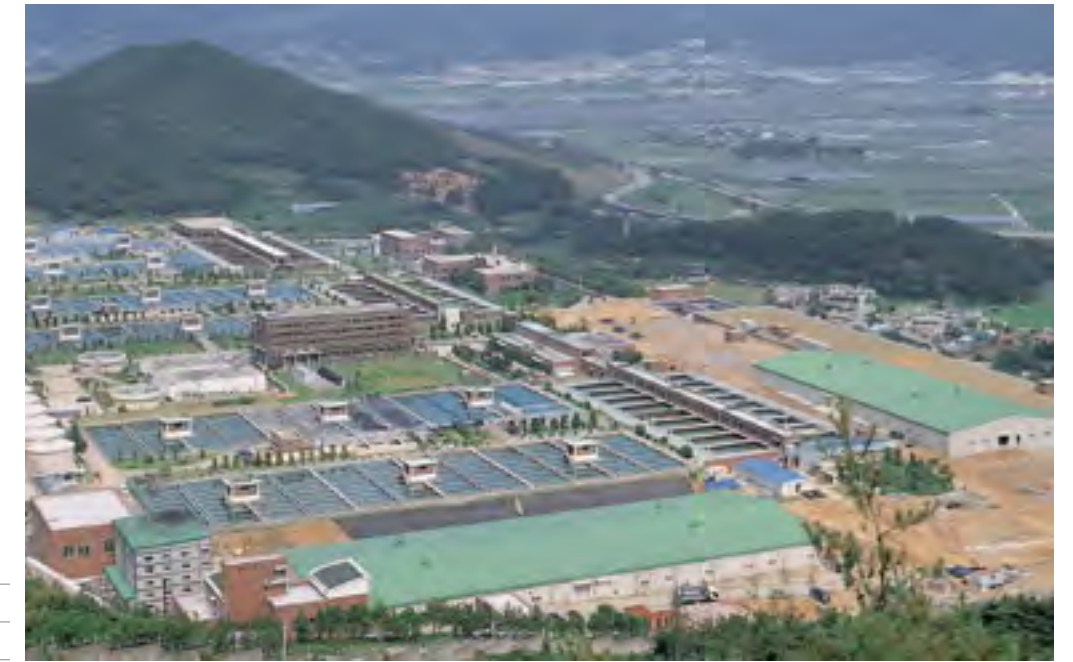
덕산 정수장 (경남 김해) 완공일 : 2000.12 *고도처리공법을 국내 최초로 도입, 턴키로 시공
