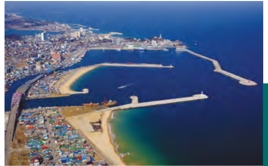
속초항 신수로 방파제 및 호안 축조 (강원 속초) 완공일 : 2012.03
