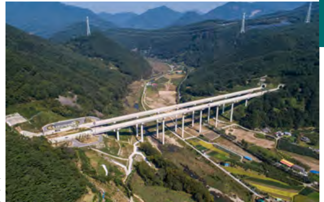
밀양 - 울산 4공구 고속국도 (밀양 - 울산) 완공일 : 2020.12 L=3.72km
