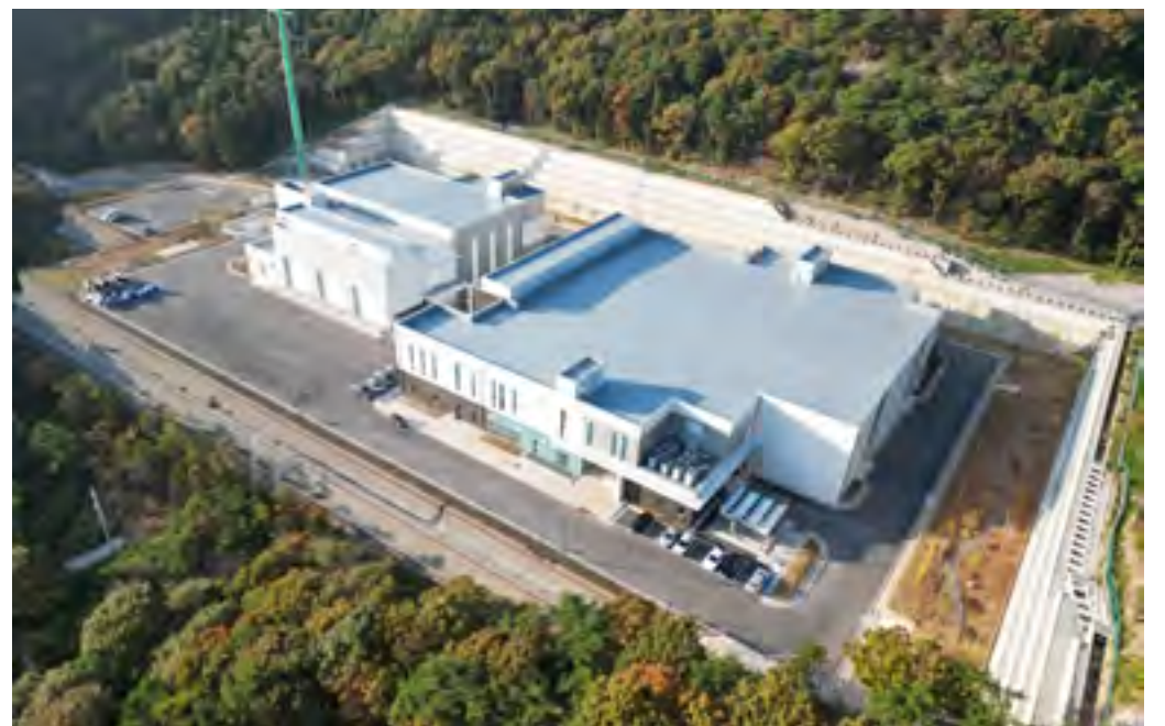
150kV 완도변환소 (전남 완도) 완공일 : 2025.07
