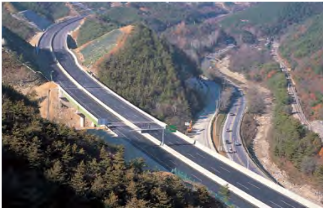
동해고속도로 (동해 - 주문진) 완공일 : 2004.12 L=8.5km
