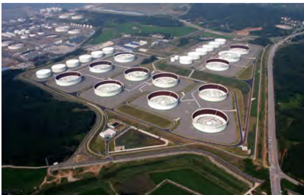
서산 비축기지 (충남 서산) 완공일 : 2005.07 *24기의 탱크 (1,460만 배럴) 규모 *수입량 기준 11일분의 원유 및 제품유 저장 가능한 대형 석유비축시설
