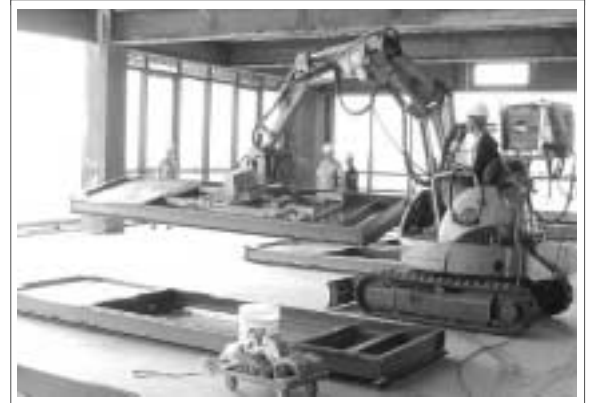
그림 3 | 초고층 빌딩커튼 월 시공 미니굴삭 로봇
